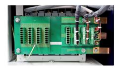
Platine de réglage de la compensation FM, à l'aide de connecteurs embrochables, permutant simultanément les 3 phases.
